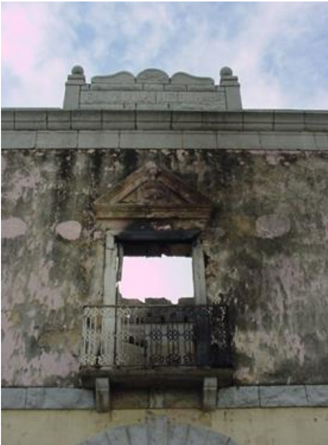
Figura 2. Detalle de la Casa Filizola en Ciudad Victoria, Tamaulipas.
